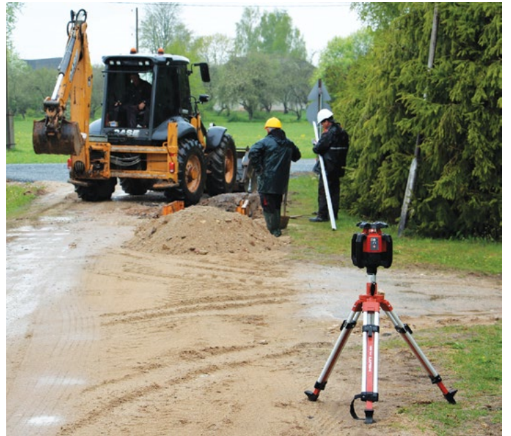
Attēlā: Dzīvojamo māju kvartālā Straupes centrā norit ūdensapgādes un kanalizācijas pārbūve. Foto: Santa Kūlīte.
