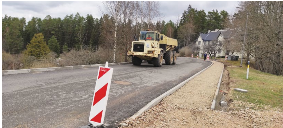
Attēlā: Gaujas ielas pārbūves darbi Līgatnē jau tuvojas noslēgumam. Foto: Egils Kurpnieks.
