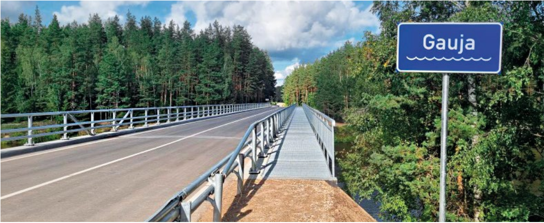
Attēlā: Septembra sākumā atvērts jaunais Gaujas tilts pie Rāmniekiem un pēc gadu ilgušiem būvdarbiem, atjaunota satiksme šajā ceļa posmā.
