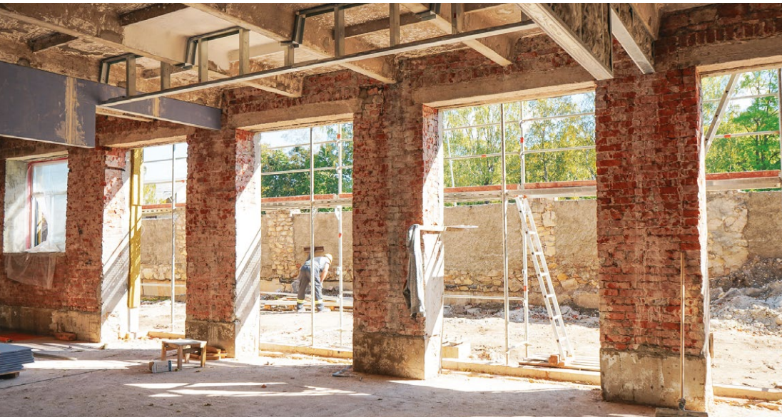
Attēlā: Radošā kvartāla “Rainis” atjaunojamā ēkā, veikta nesoso konstrukciju stiprināšana.
