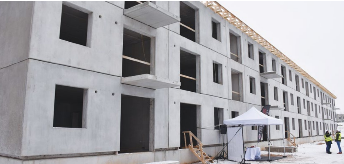
Attēlā: Lāču ielā 9 top zemas īres maksas daudzdzīvokļu nams ar mājokļiem 56 ģimenēm. Foto: Aleksandrs Abramovs.
