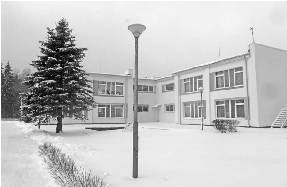
Renovētā Taurenē pamatskolas ēka.
