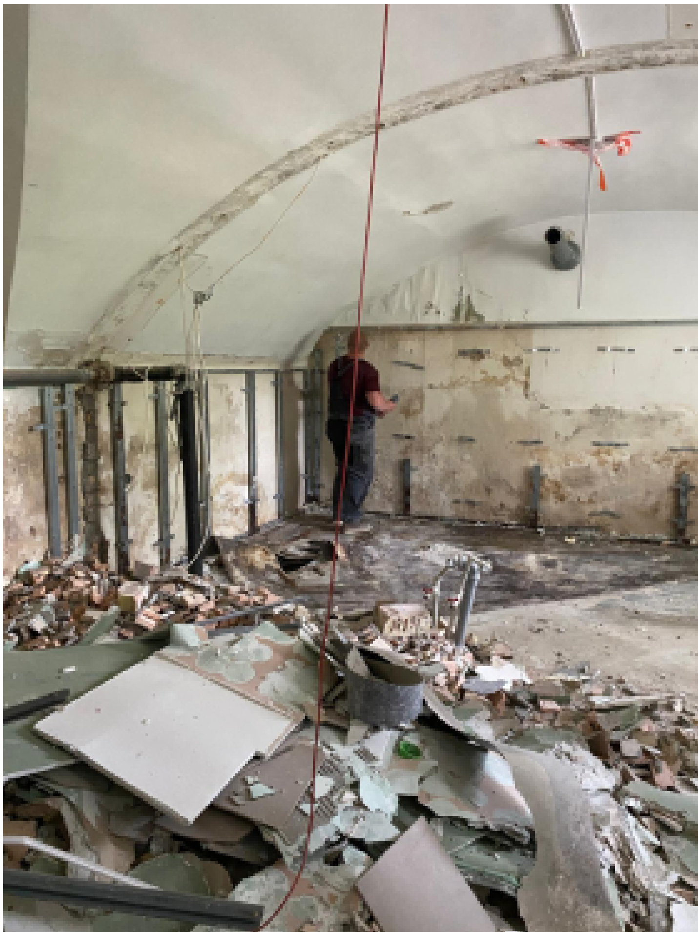
Projekts Nr. 3.1.1.5.i.0/1/24/I/CFLA/009 "Izglītības iestāžu infrastruktūras pilnveide un aprīkošana Cēsu novadā" tiek īstenots Eiropas Savienības Atveseļošanas un noturības mehānisma plāna 3.1.1.5.i investīcijas "Izglītības iestāžu infrastruktūras pilnveide un aprīkošana" ietvaros. Kopējās projekta izmaksas ir 3 793 412.92 EUR ar PVN, no kurām
