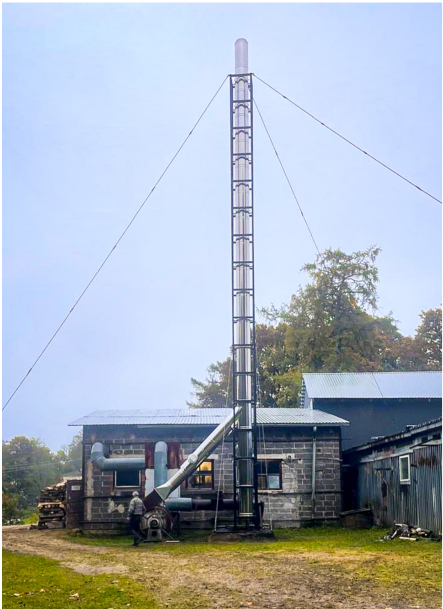
Taures katlu mājā uzstādīts jauns skurstenis, vecais tika nomainīts saskaņā ar skursteņslauķa atzinumu.
